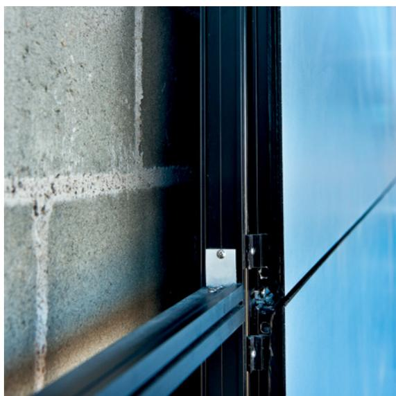
Sistema de fixação oculto: a estrutura de fixação é constituída por uma subestrutura auxiliar em alumínio, composta por perfis verticais e horizontais, que posteriormente recebem o Laminum. O Laminum é aderido em um perfil periférico por um selante estrutural formando um quadro.
