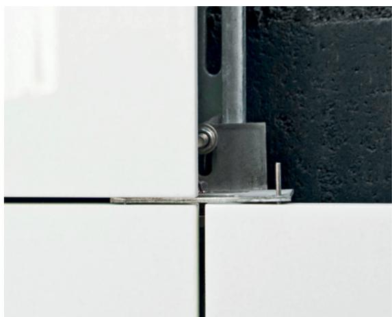
Sistema de fixação oculto: a estrutura de fixação é constituída por inserts metálicos pontuais inseridos na borda do Crystalato (que possui espessura de 15mm).
