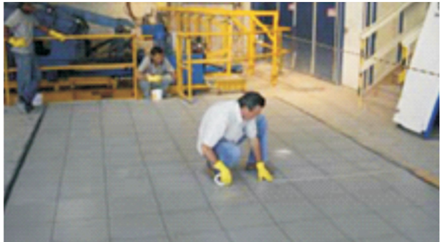
Metrô São Paulo - Fábrica de Aduelas - Linha Amarela
